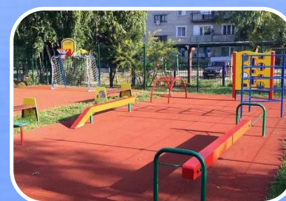
Обустройство спортивной площадки МБДОУ "Детский сад "Ягодка" с. Владимиро - Александровское
