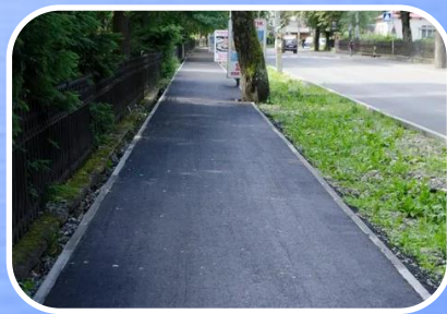
Устройство тротуара по ул.Комсомольская
