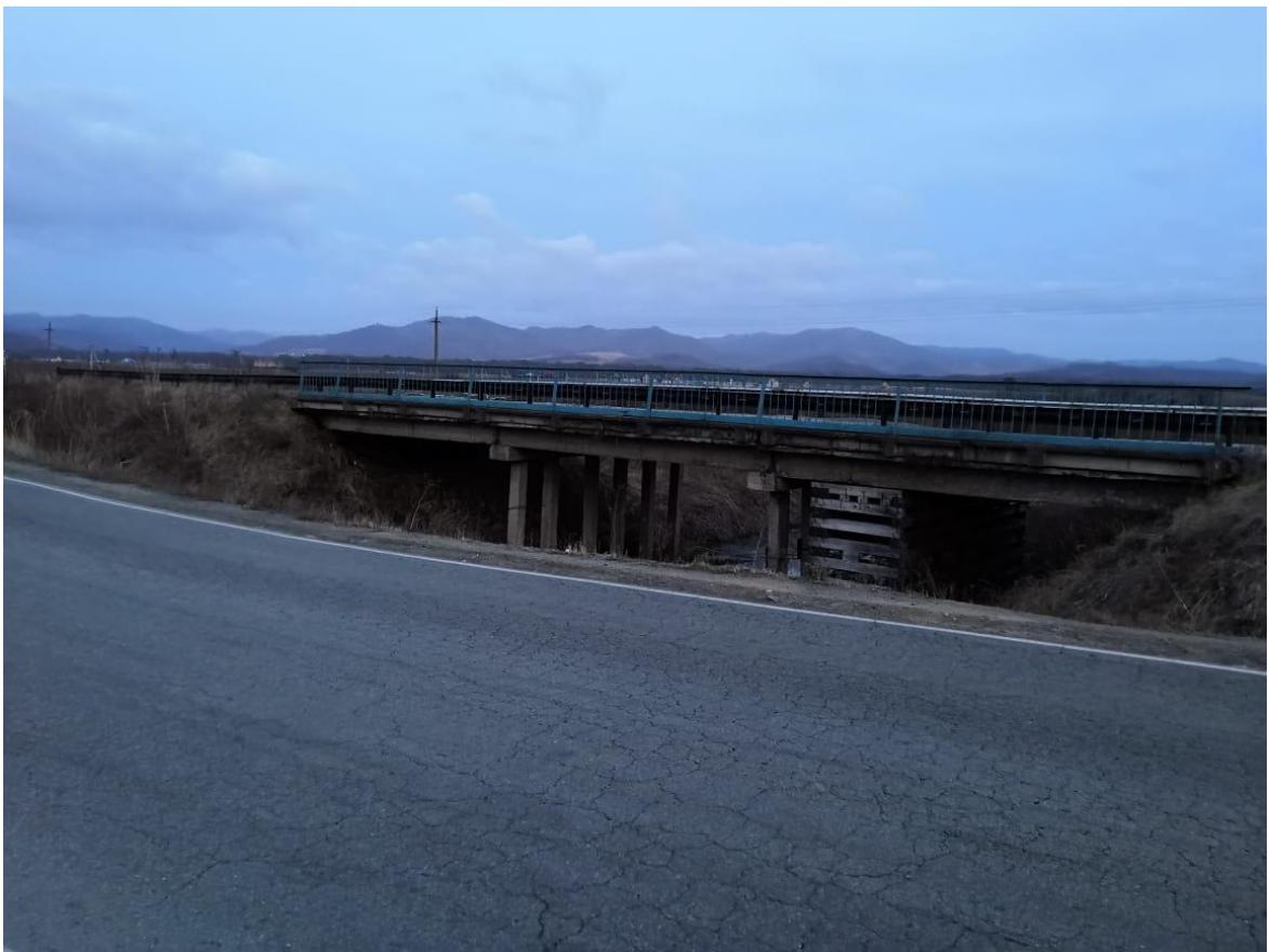
Рисунок Ж.6 – Общий вид моста
