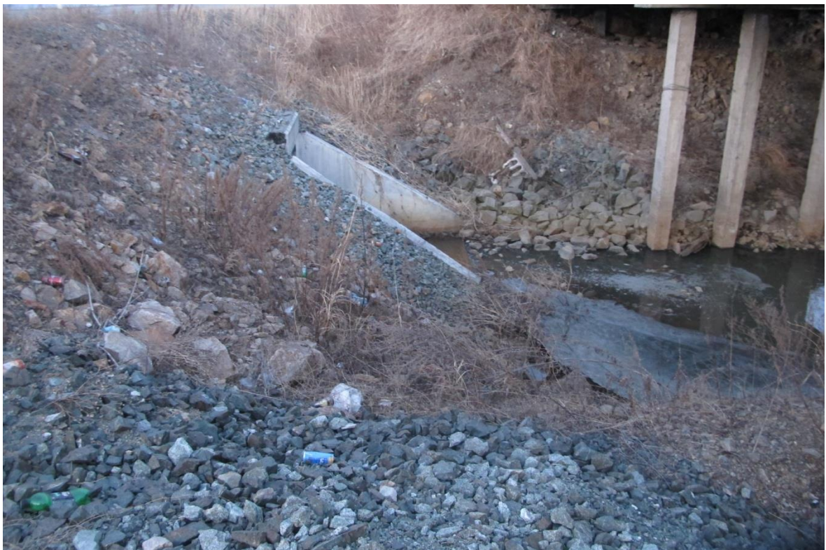
Рисунок Ж.4 – Вид на железобетонную трубу через ручей без названия на объездной дороге выше моста
